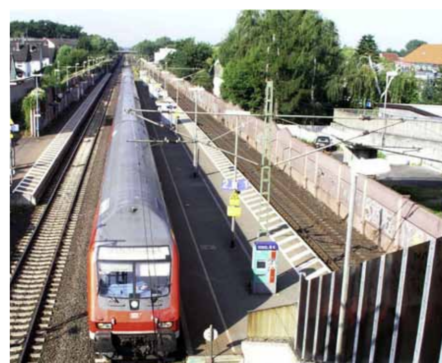
Niederrodenbach ist seit 1869 durch einen Haltepunkt an das Bahnnetz angeschlossen.
